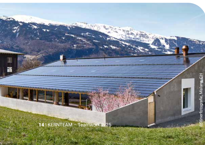
Fugen durchlaufend, halb oder ungleichmäßig versetzt
